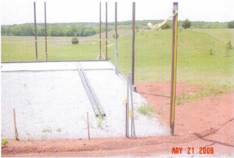
3 pours of concrete
