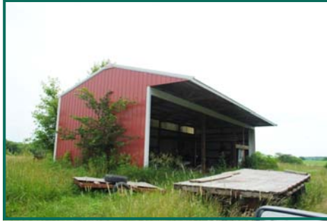
Parcel 1 - Pole Barn
