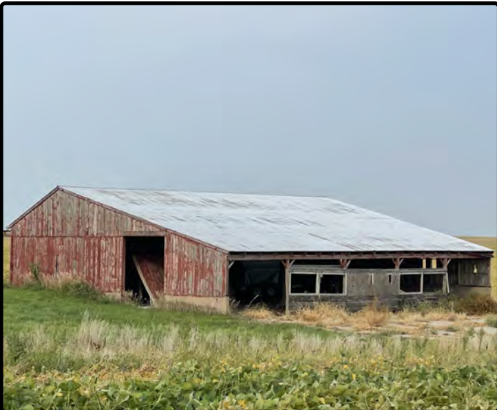
Parcel 4 - Pole Barn
